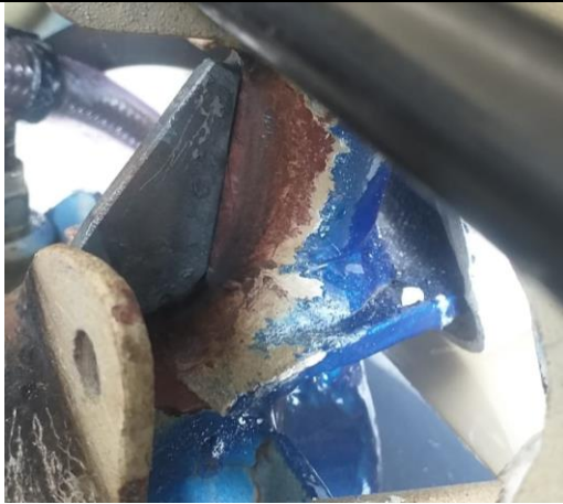
Figura 14 – Fixação da peça para a soldagem Figure 14 - Fixture of the part for welding
