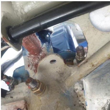
Figura 9 – Vista 1 da área do metal lixada Figure 9 – View 1 of the sanded metal area
